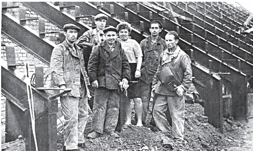
Бригада арматурщиков цеха № 68.
